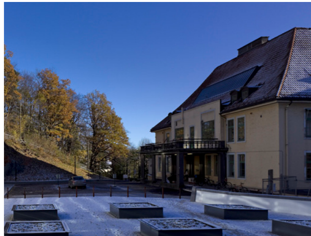
Figur 17: Bygg F sett fra hotellplassen
