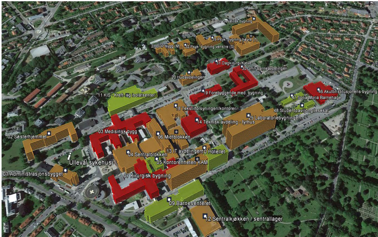
Oversikt teknisk tilstand Ullevål sykehus , 2017
