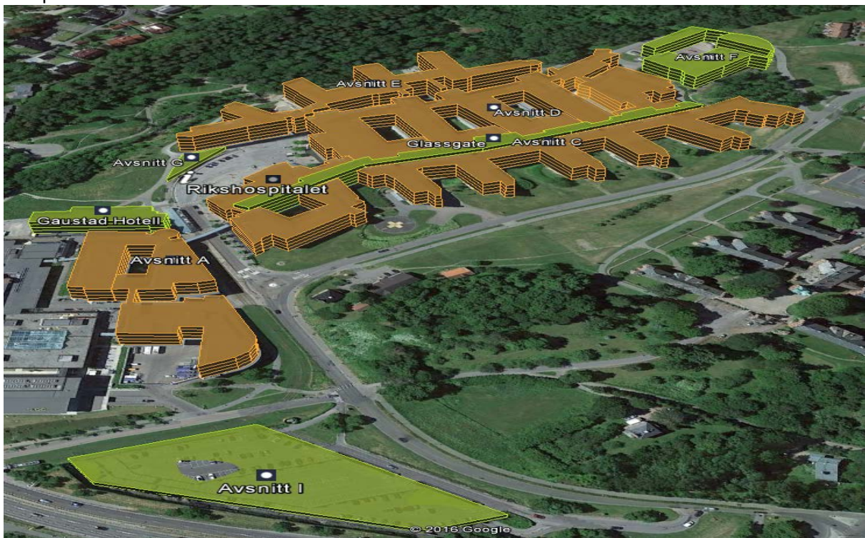
Oversikt teknisk tilstand Rikshospitalet, 2017
