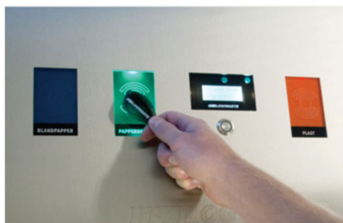
System med selektering i nedkast
