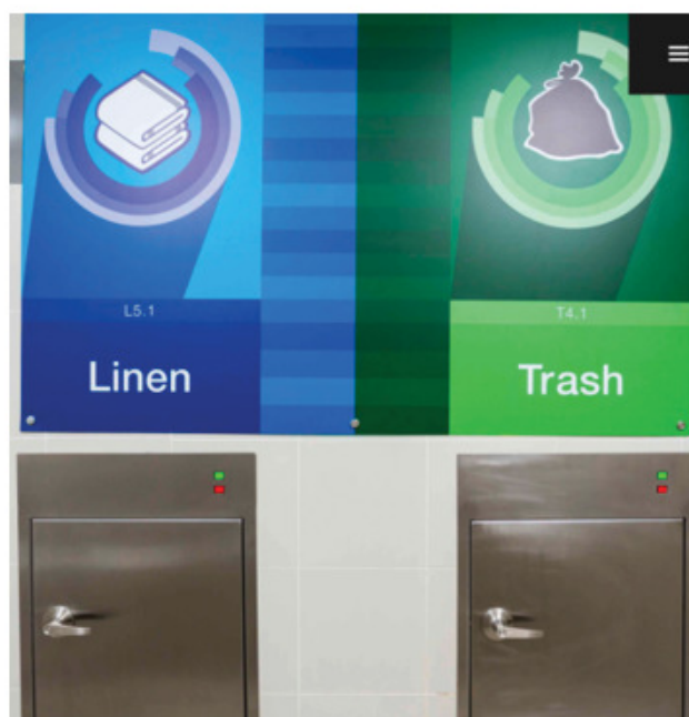
Separate nedkastsjakter for avfall og tøy.
